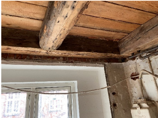
Billede – synlig træbjælkelag uden loftbeklædning
