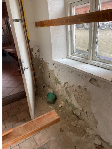
Billede – afskalninger i indvending puds
