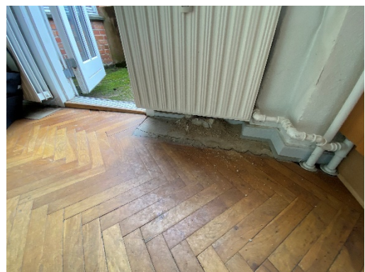
Billede – betonstøbning i køkken mod altan (1. sal)
