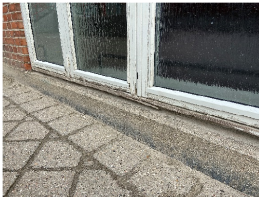
Billede – malerafskalning på vindue
