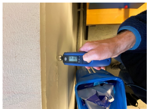
Billede – måling af fugt i kældervægge
