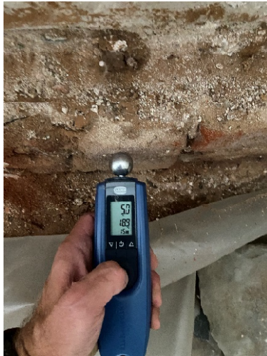
Billede – måling af fugt i ydervægge (hovedhus)
