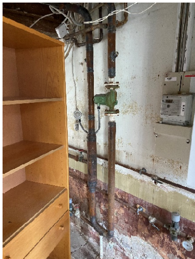
Billede – eksisterende vand- og varmeinstallation
