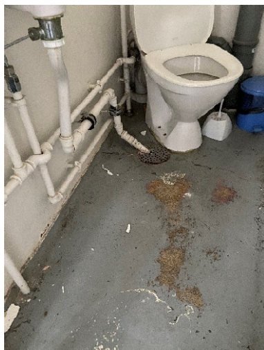
Billede – revner i betongulv og slidt malebehandling
