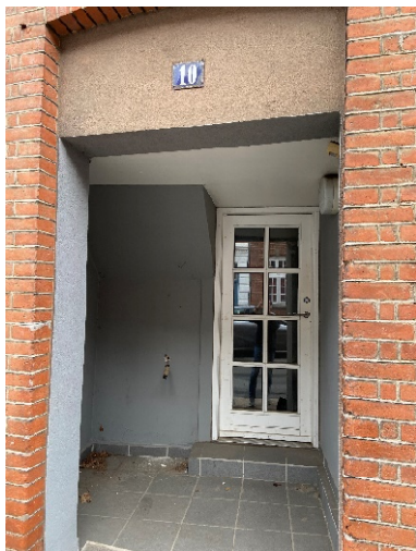
Billede – let ydervæg uden isolering
