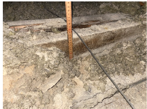
Billede – isoleringstykkelse og dampspærre
