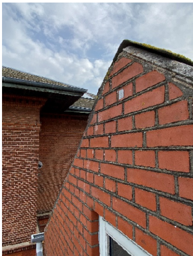
Billede – tagbeklædning afsluttet glat med facaden
