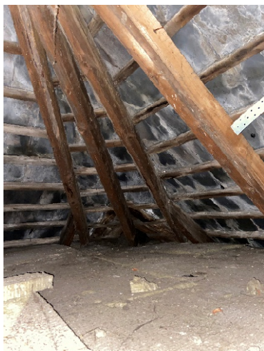
Billede – udvendigt taghjørne med lyshuller
